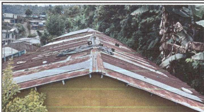
Foto 1: Sustitución de lamina por lamina Troqueladfa Aluzinc. Calibre 26 exacto son 297 m2
