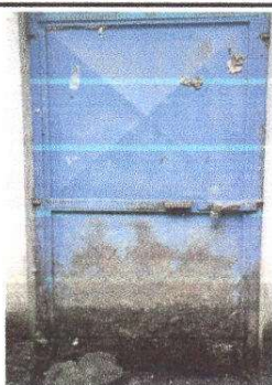
Foto 5: Sustitución de 5 puerta de metal de 1 metro de ancho por 2.70 metros de alto
