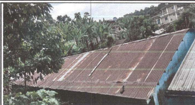
Foto 2: na por lamina Troqueladfa Aluzinc. Calibre 26 exacto
