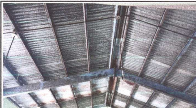
Foto 4: Mantenimiento a estructura soporte de metal
